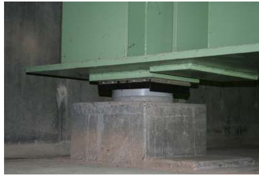
FIGURE 6.20 – Liaison sphère-cylindre, dite de type « appui glissant ».
