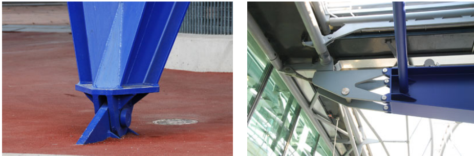
FIGURE 6.18 – Exemples de liaisons sphériques.
